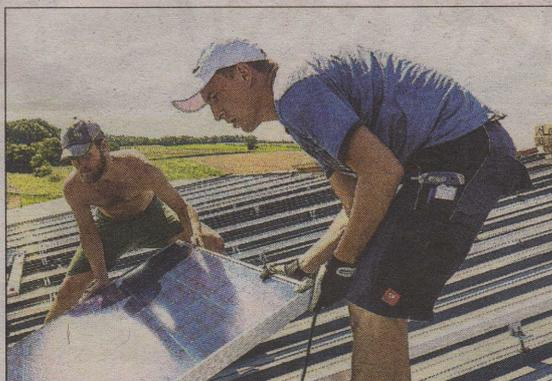
jektes. Die Anlage ist gegen Süden ausgerichtet, und da auf einen idealen Neigungswinkel geachtet wurde, müssen die Module nicht aufgestellt werden. Stattdessen werden sie direkt auf dem Dach montiert.
